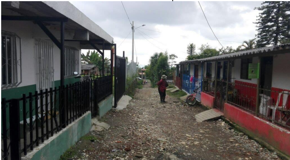
Imagen 29. Estado del camino de acceso al centro poblado La 18
