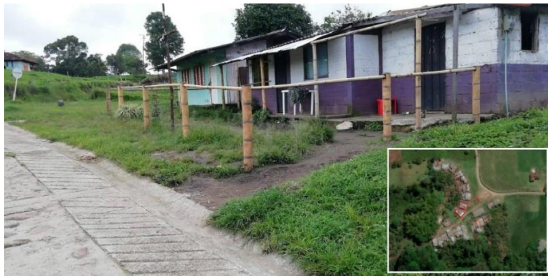
Imagen 35. Viviendas autoconstruidas en la vereda Membrillal.
