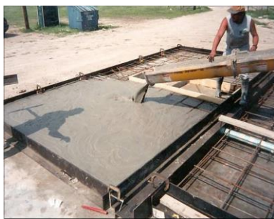
Fotografía. 5.1 Vaciado de hormigón Extraído de http://www.litebuilt.com/pic/hot04d.jpg
