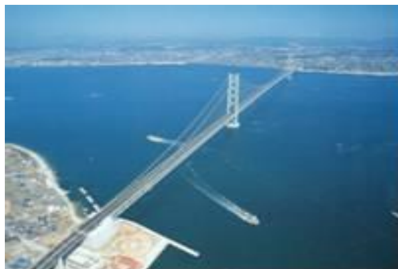
Fotografía. 7.4 Anclaje del Puente Akashi Kaikyo (Ozawa et al., 1999)
