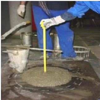
Fotografía. 2.1 Prueba de asentamiento al HC (De La Cruz, 2006)
