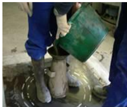
(b) vertido del hormigón
