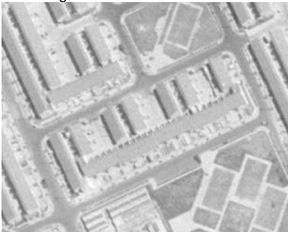
Imagen 4-13 Transformación de manzana en 1990 y en la actualidad Aerofotografía 1990
