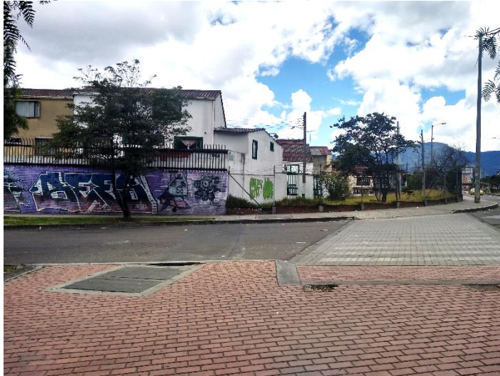
Fotografía 4-2 Culatas en el Espacio Público
