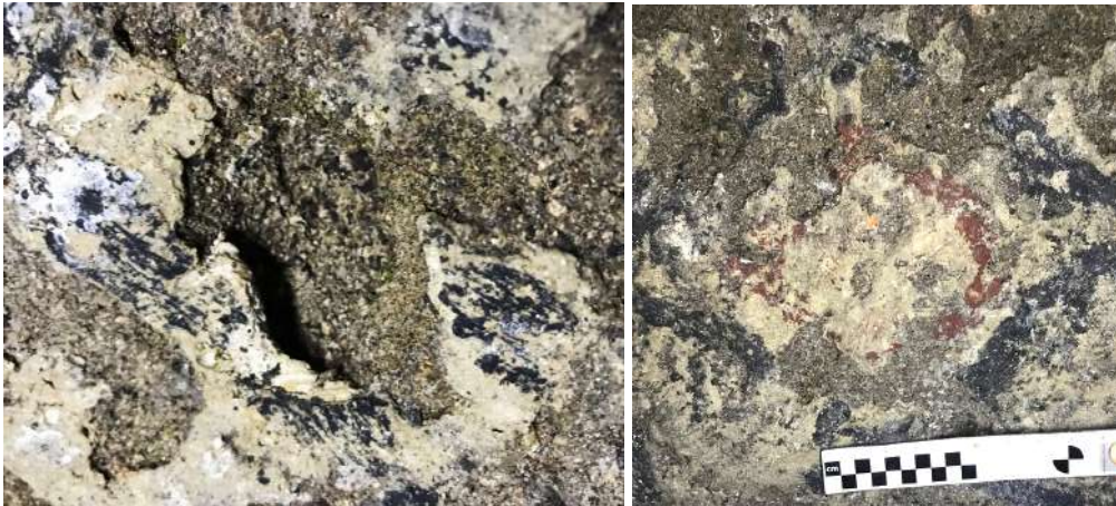
Figuras 6-4 & 6-5: Desprendimientos de soporte, capa de preparación y pinturas.
