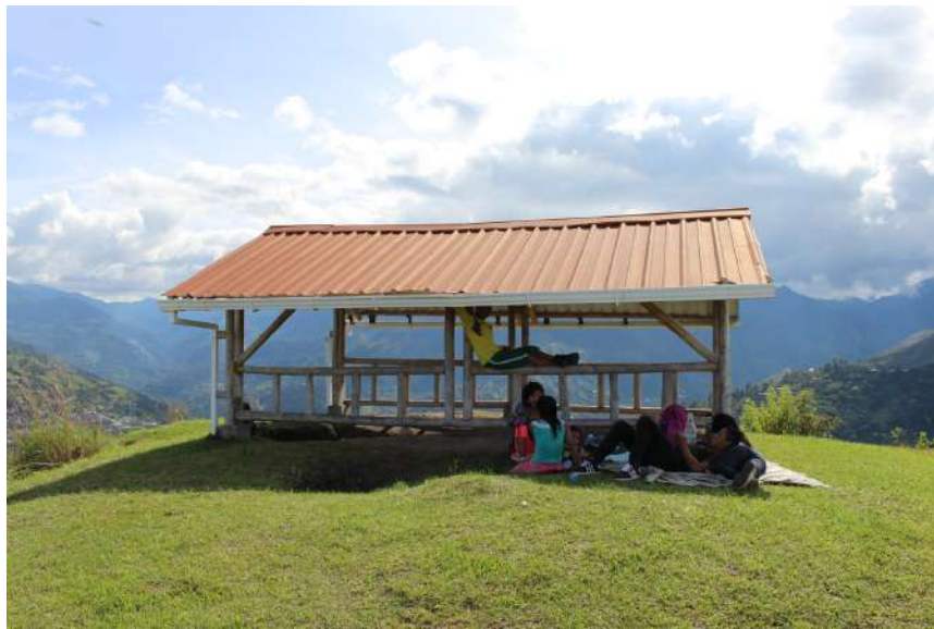
Figura 6-19: Estructura ubicada al final del recorrido del Alto del Aguacate.
