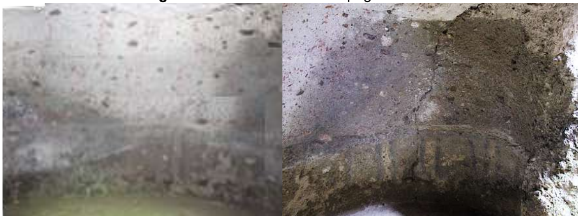
Figuras 3-28 & 3-29: Parte central (izq) Lado izquierdo (der). Hipogeo AR-50.
