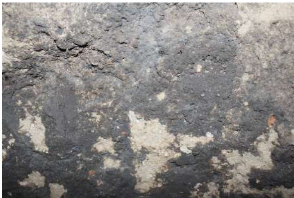
Figura 6-8: Capa de tierra en el Hipogeo AR-50
