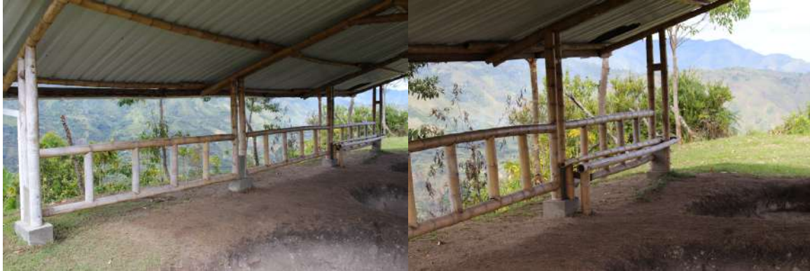
Figuras 6-2 & 6-3: Techos instalados en el Alto del Aguacate.
