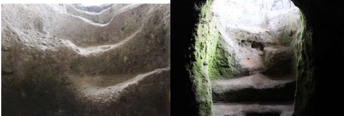
Figuras 6-17 & 6-18: Escaleras deterioradas en los Hipogeos AR-38 (izq) y AR-44 (der).
