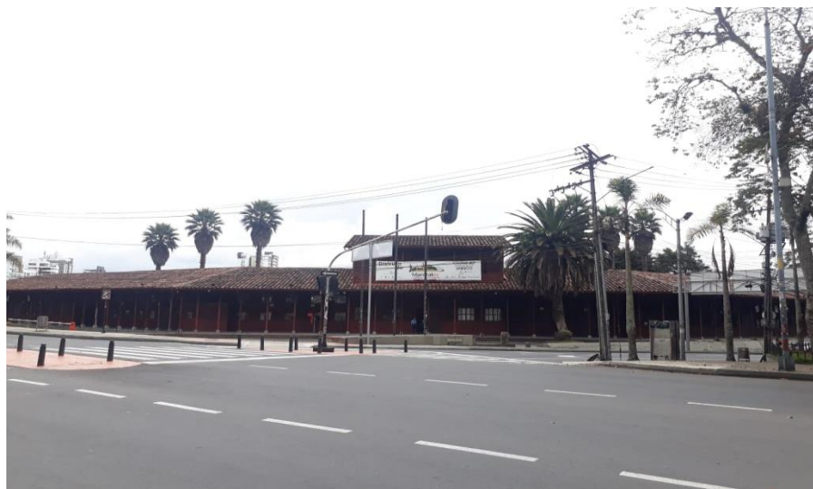
Figura 25. Ubicación Estación Facultad De Arquitectura Universidad Nacional De Colombia (Fuente Propia)
