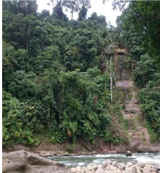
Figura 94. Caída de bloques en el sector de las Garzas (E=1.163.543 N=673.935)
