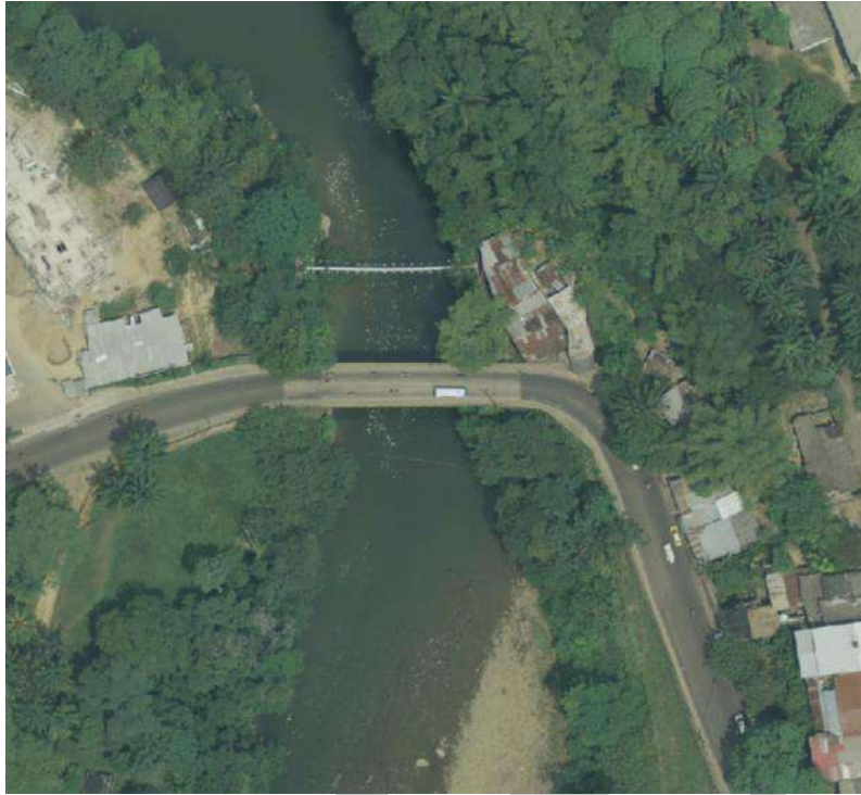
Figura 28 Segundo puente río Hacha.
