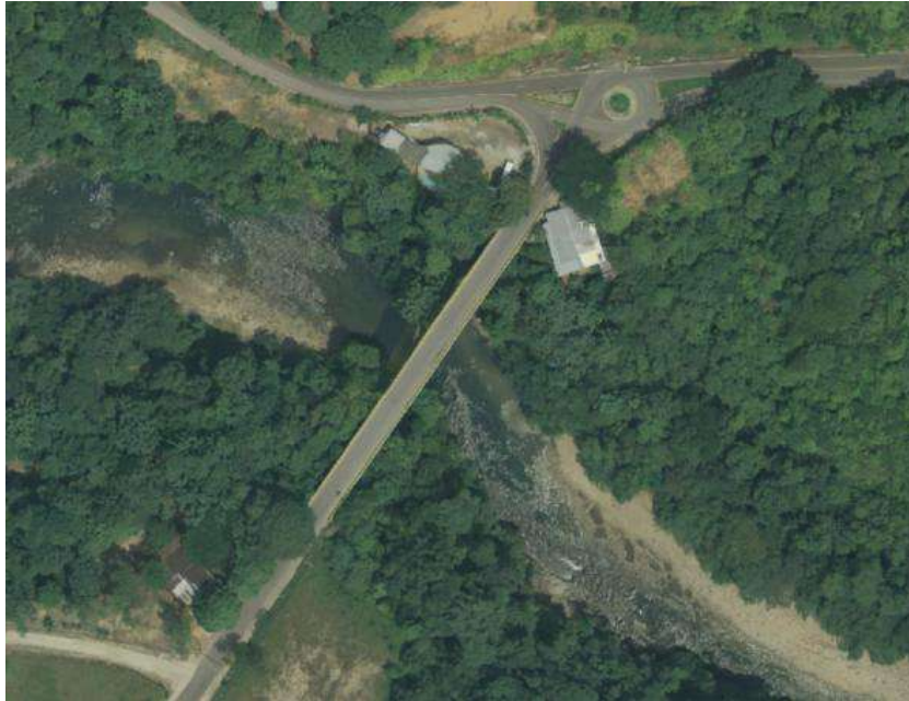
Figura 26 Primer puente río Hacha.
