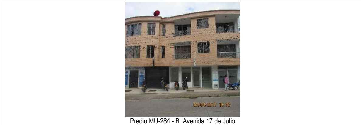
Figura 227. Fotografías del estado de conservación de las construcciones en el área de estudio.
