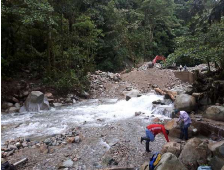
Figura 169 Sector de la Bocatoma del Acueducto
