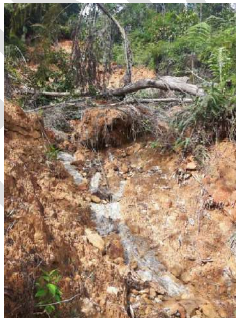
Figura 154 Deslizamiento localizado en la cuenca alta del río Mulato, (1°08'59.92" N, 76°40'50.98" W)
