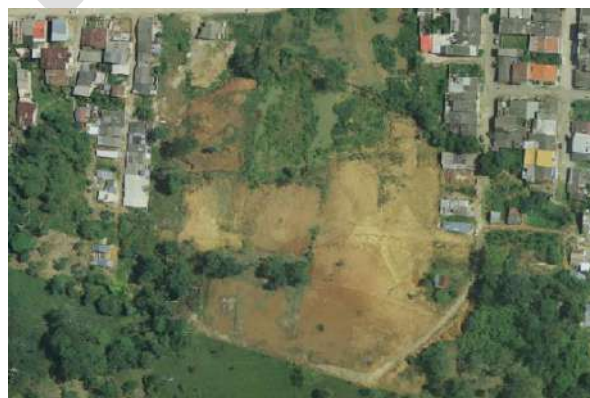
Figura 101. Loma denudada fuertemente erosionada en la cuenca del río Mulato.
