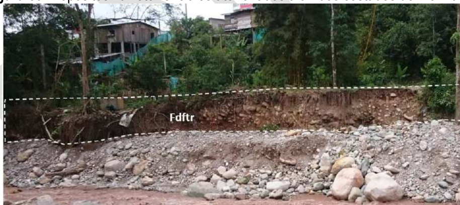
Figura 90. Construcciones de la vereda Villanueva sobre depósito fluvio-torrencial aterrizado reciente (E=1.047.022 N=618.308).
