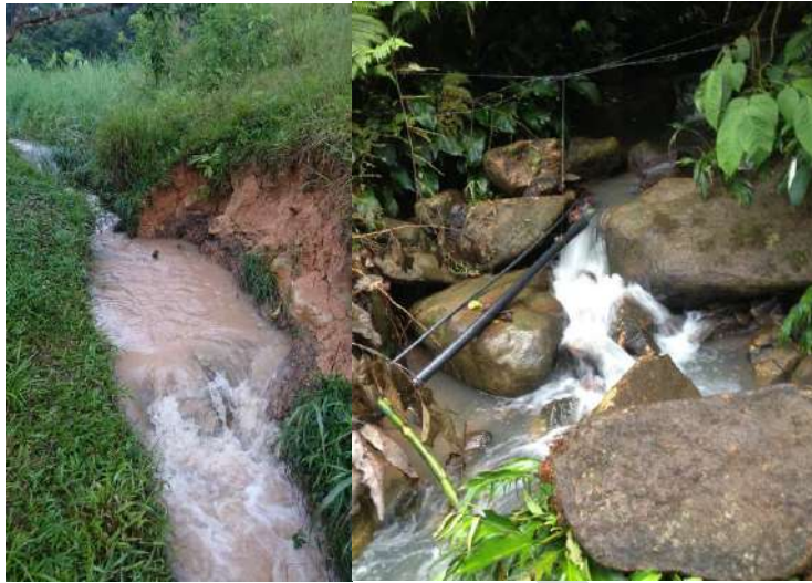
Figura 97. Canales secundarios del río Mulato (a. E=1.045.687 N=618.524; b. E=1.046.622 N=618.118). Fuente: Equipo Rondas Hídricas
