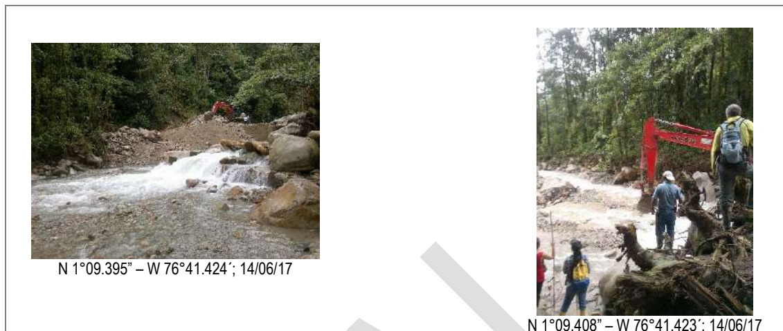
Figura 19. Remoción de material del lecho del río Mulato a la altura de la bocatoma
