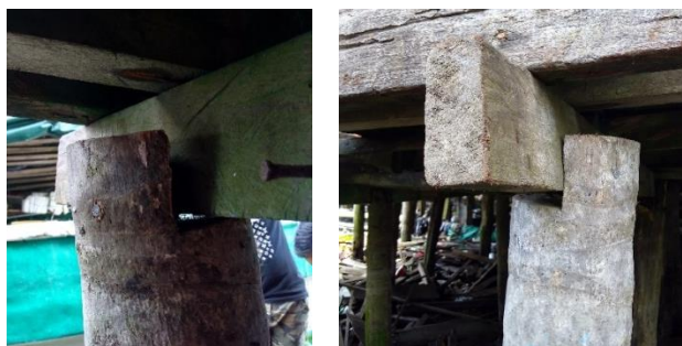
Figura 4-9. Uniones típicas de las construcciones palafíticas
