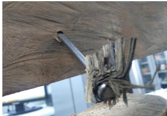
Figura 5-27. Mecanismo de colapso de la unión a momento
