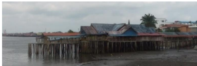
Figura 4-1. Estructura de Palafito típicas
