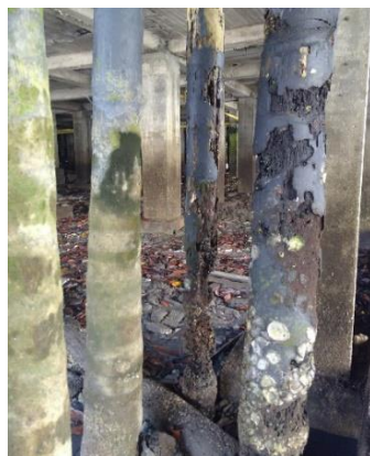
Figura 4-10. Impermeabilización de la madera
