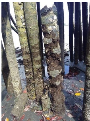
Figura 4-2. Reemplazo de elementos estructurales
