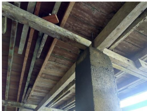
Figura 4-8. Pilares de concreto reforzado
