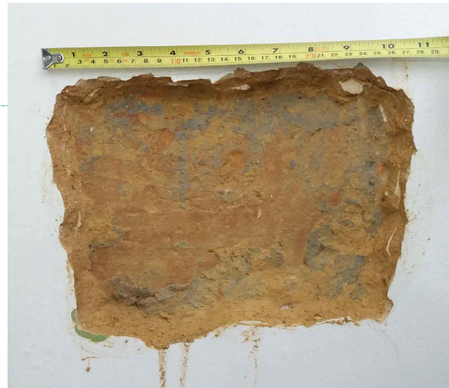
EXPLORACIÓN 8 Tableta de 15 cm de alto aprox. Doble pañete de cal y arena de 3,5 cm. Primer pañete de 1,5 cm. Segundo pañete de 2 cm.
