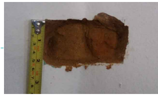
EXPLORACIÓN 5 Ladrillo militar 5 cm aprox. Pañete de cal y arena de 3 cm.
