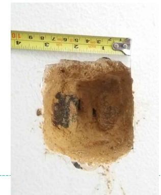
EXPLORACIÓN 6 Ladrillo militar 5 cm aprox. Doble pañete de cal y arena de 3,5 cm Primer pañete de 1,5 cm. Segundo pañete de 2 cm..
