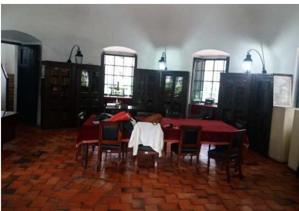
Figura 207. Aspecto del contrapiso Fuente: Elaboración propia
