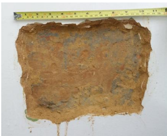
Figura 144. Exploración donde se observa la tableta de cerámica.
