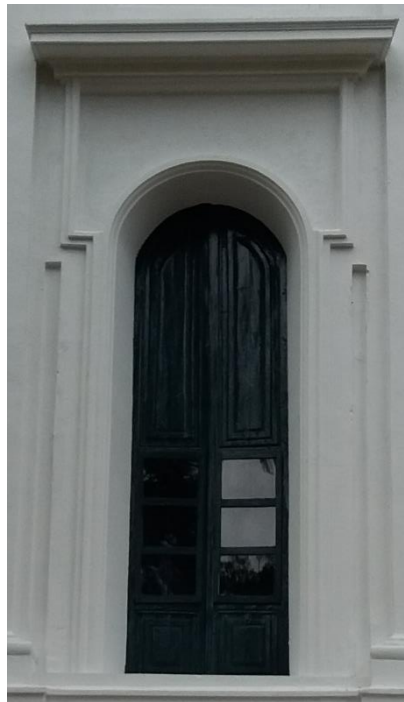
Figura 176. Exterior ventana segundo nivel. Fuente: Elaboración propia.
