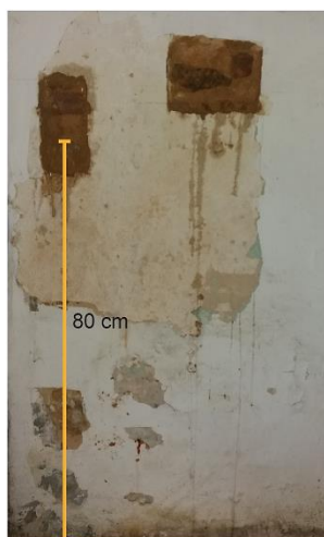
Figura 140. Exploración donde se observa el sobre cimiento del salón bajo. Fuente: Elaboración propia.
