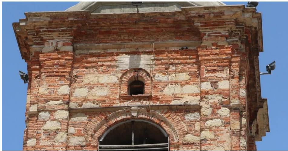
Figura 29. Detalle obra de mampostería Catedral de Zipaquirá.
