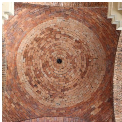
Figura 152. Detalle aparejo cúpula catedral de Zipaquirá
