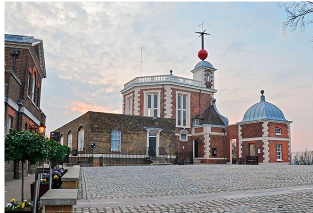
Figura 17 Edificio antiguo Observatorio de Greenwich
