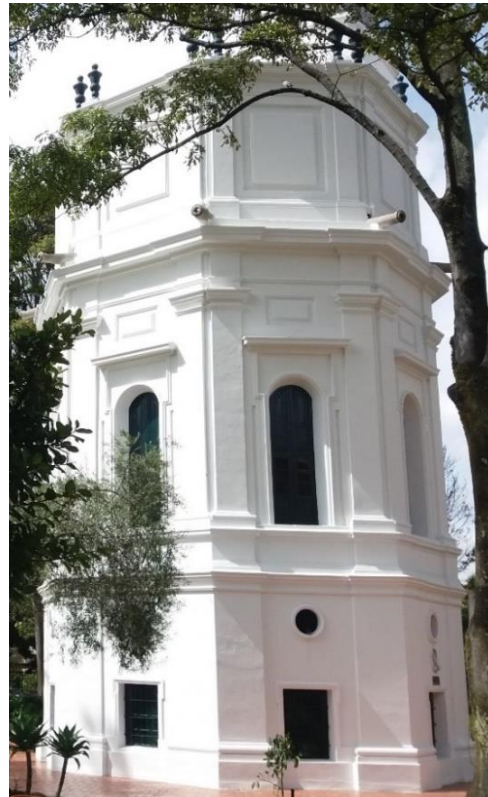
Figura 99. Fotografía de fachada.
