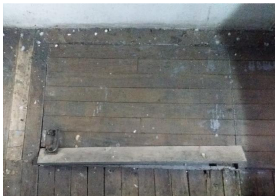
Figura 181. Puerta escotilla del cuarto del telescopio.
