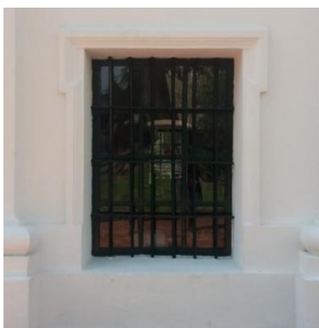
Figura 250. Carpintería de ventanas Fuente: Elaboración propia.
