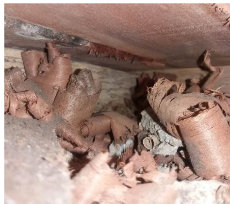
Figura 229. Intervención del entpiso.
