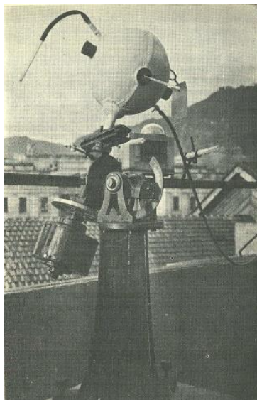
Figura 49. Actinómetro de Violle. Instrumento empleado para la radiación solar instalado en la terraza del observatorio Fuente: __ Anuario de la Universidad Nacional de Colombia (1939) Editorial Santafé. Bogotá.
