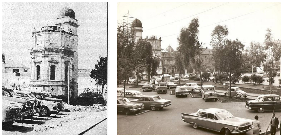
Figura 124. Pérdida de los exteriores del observatorio. Ca. 1960
