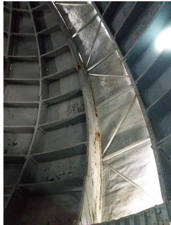
Figura 240. Daños en la cúpula metálica.
