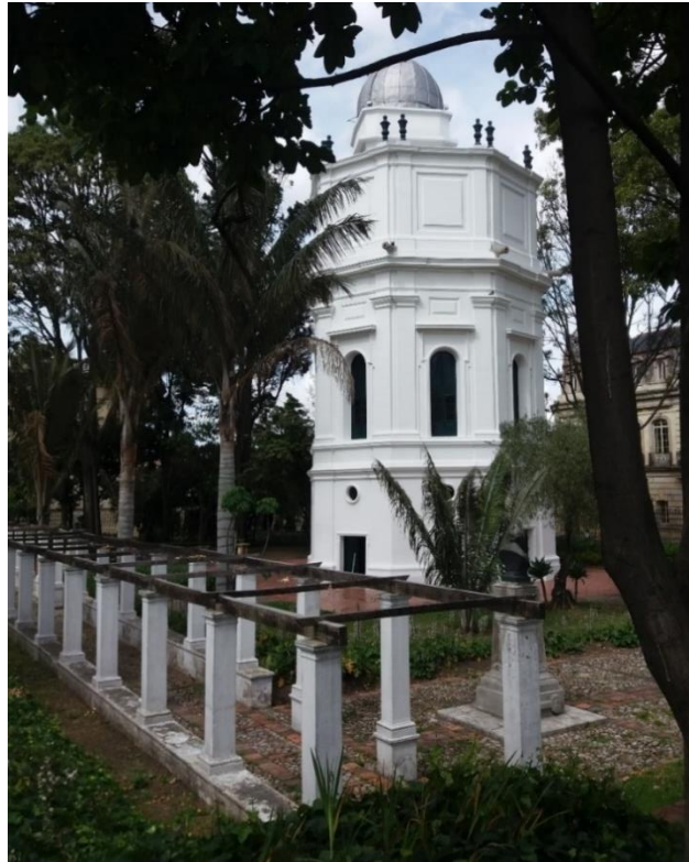
Figura 135. Pérgola en el costado oriental del edificio.
