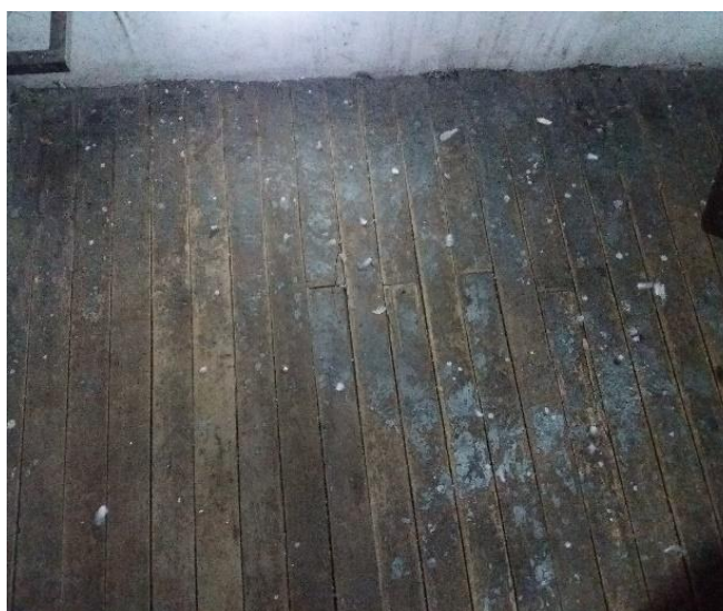
Figura 239. Acabado de piso de madera cuarto del telescopio. Fuente: Elaboración propia
