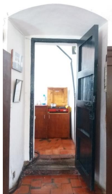
Figura 171. Puerta entre salón bajo y torre de la escalera.
