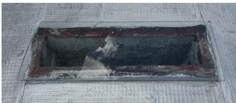
Figura 235. Vidrio suelto tapando la abertura.
