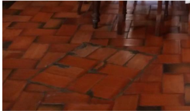
Figura 254. Acceso a caja de inspección Fuente: Elaboración propia.
