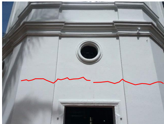
Figura 212. Empuje de la cúpula sobre el muro.
