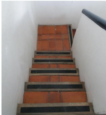
Figura 168. Detalle acabado de escalera.
