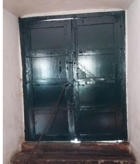
Figura 247. Parte posterior puerta de acceso al observatorio.
