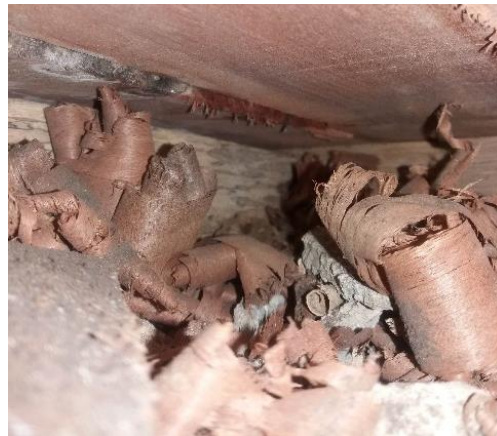
Figura 156. Relleno de espacio entre la cúpula y en entrepiso. Fuente: Elaboración propia.
