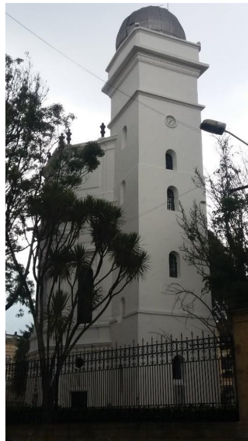
Figura 105. Fotografía de fachada.
