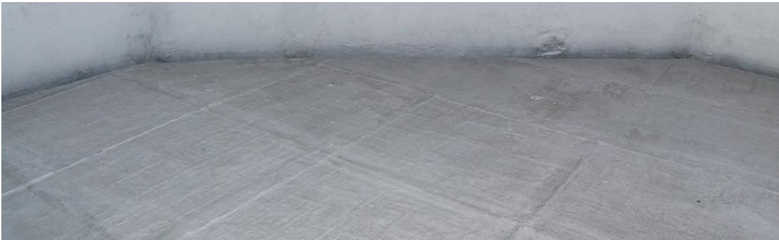
Figura 160. Foil de aluminio terraza.
