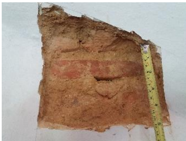
Figura 141. Exploración donde se observa el ladrillo militar. Fuente: Elaboración propia.
