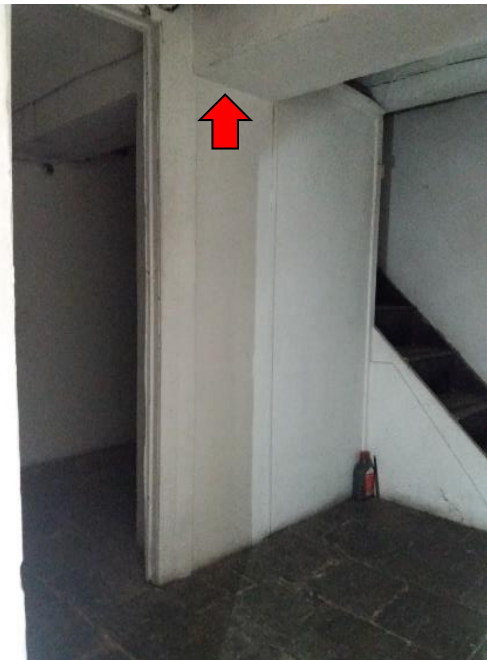
Figura 236. Presencia de viga de concreto en entrepiso.
