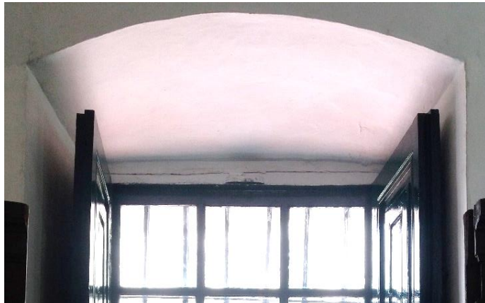
Figura 226. Presencia de vanos tapiados Fuente: Elaboración propia
