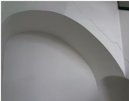
Figura 110. Bóveda catalana de la escalera del Observatorio.
