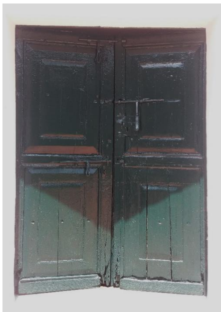
Figura 170. Puerta de acceso al edificio.
