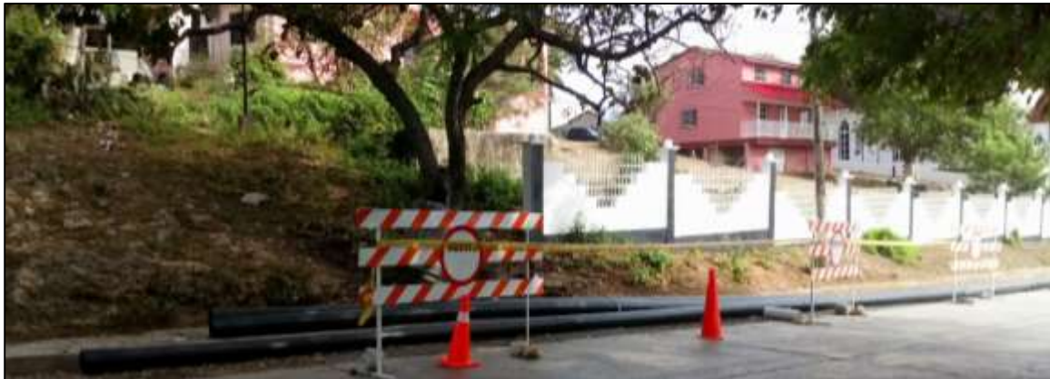
Foto 2-29: instalación de nuevas tuberías en La Loma.
