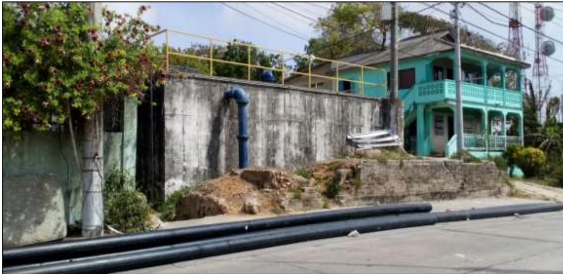
Foto 2-12: instalación de tuberías de acueducto en La Loma.
