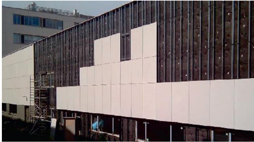
Figura 2- Uso de MRC para paneles de fachada
