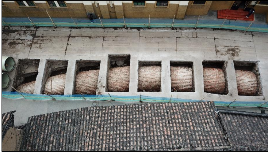
Fotografía 4-6: Vista aérea Estructura abovedada, canalización Quebrada Mijitayo. Cra27 entre calles 12 y 13.
