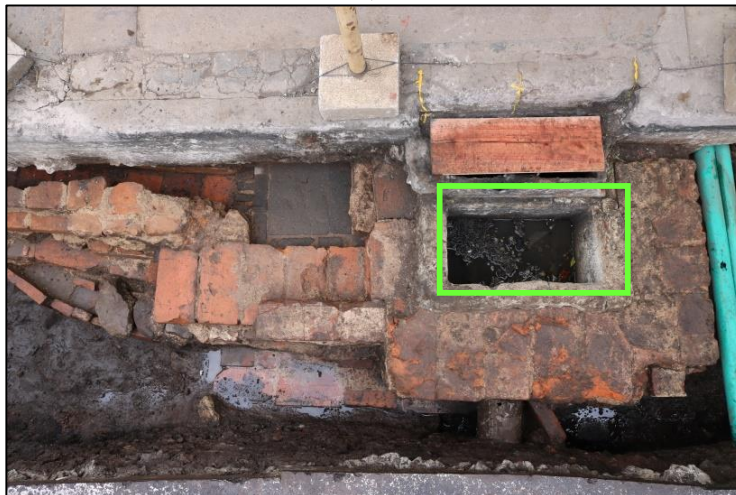
Fotografía 4-4: En rectángulo verde se observa el sumidero contemporáneo que intervino la estructura en ladrillo, asociada con el resto del canal.
