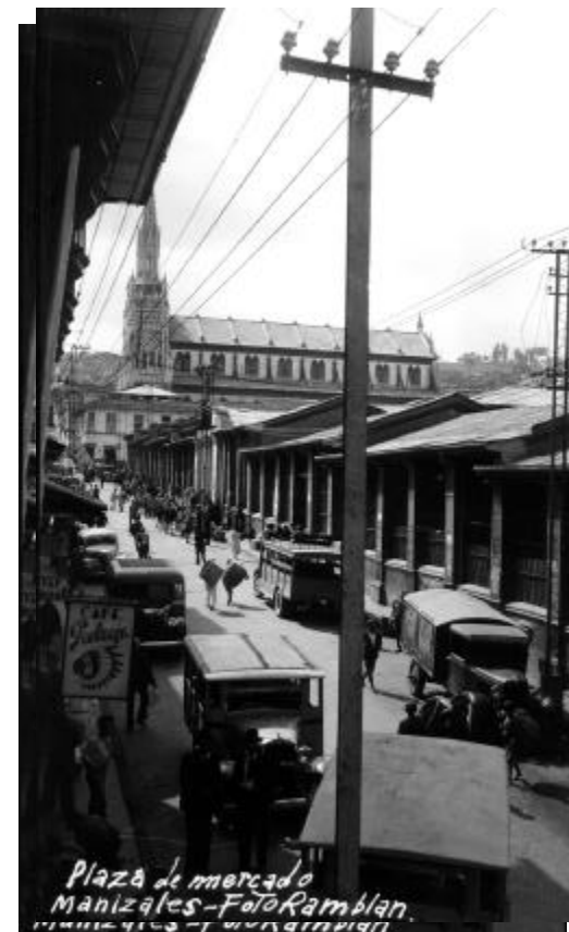
FOTO N° 4. Plaza de mercado o galerías - Al fondo templo de los agustinos Costado norte
