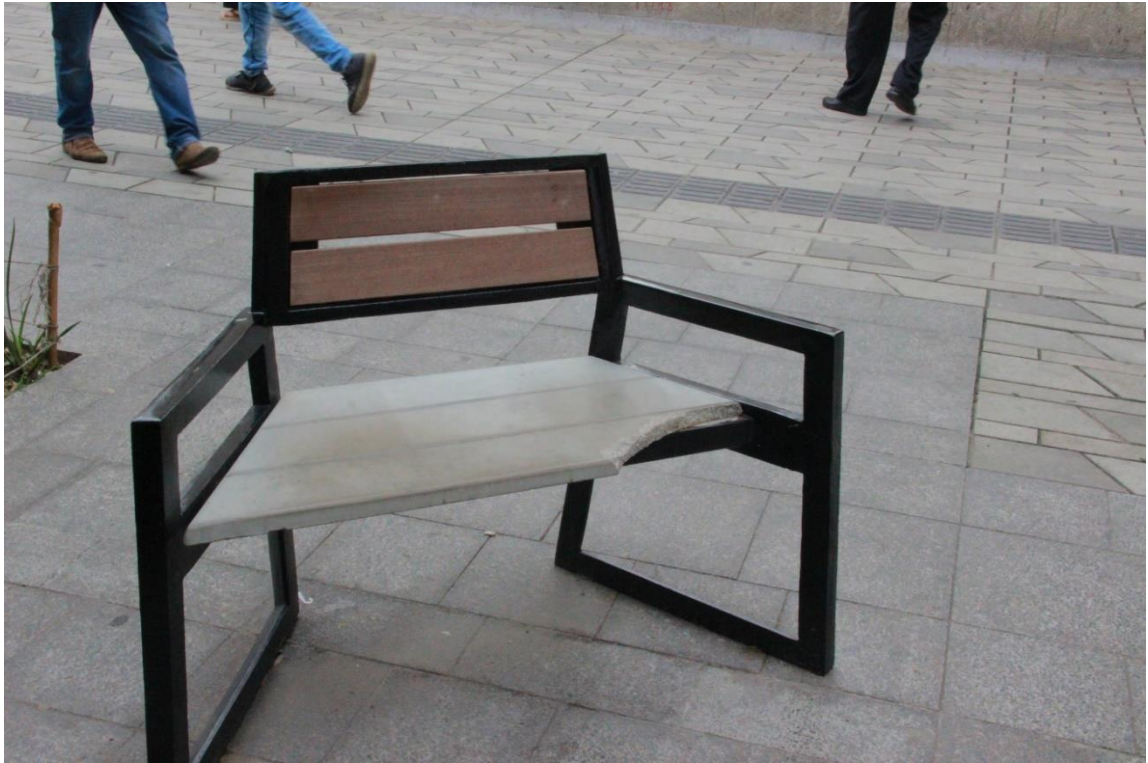
Ilustración 4-19 Daño al amueblamiento urbano (sillas) por intento de desmantelamiento en Paseo Bolívar entre Ayacucho y Pichincha.
