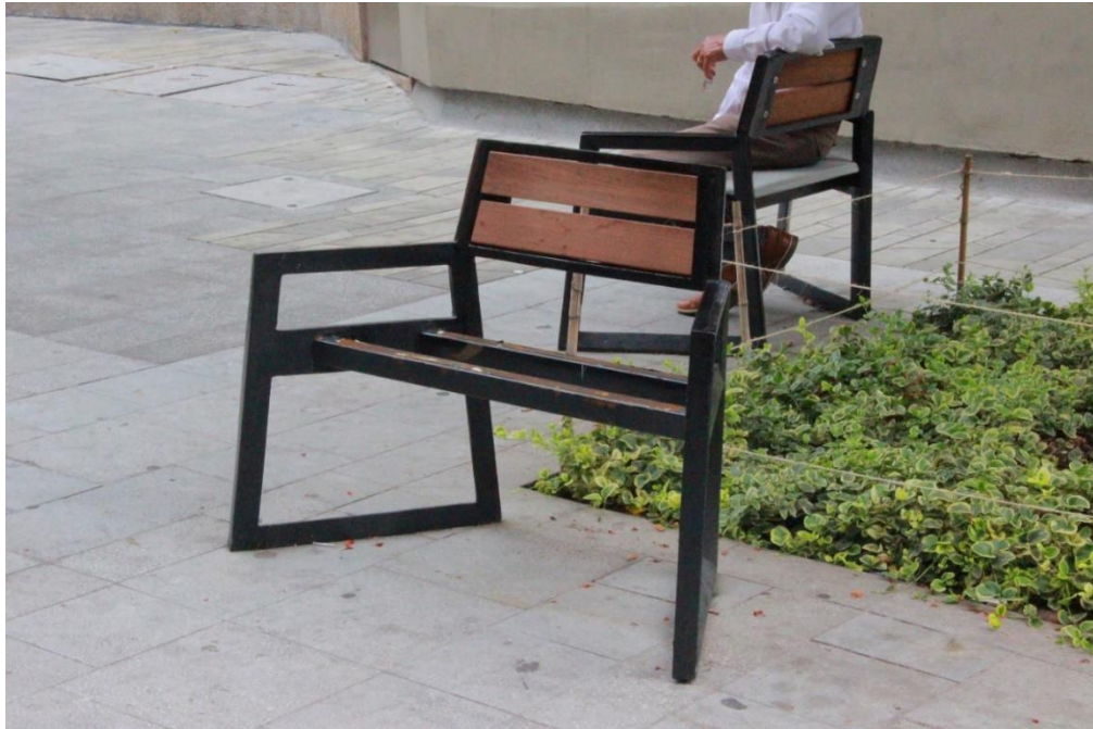
Ilustración 4-13 Desmantelamiento de bancas en el Paseo Bolívar entre Colombia y Ayacucho.
