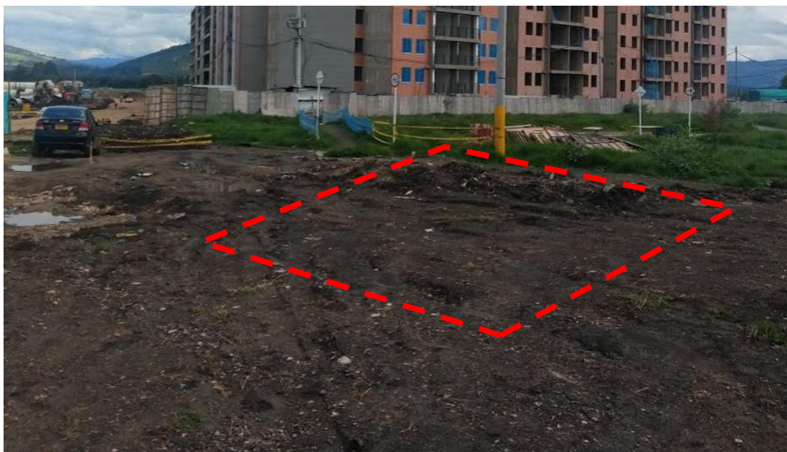
Figura 10-1. Limpieza de terreno
