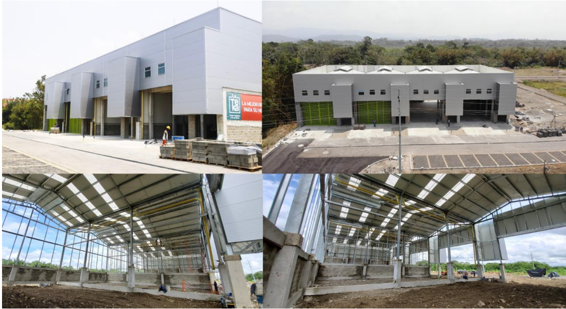
Imagen 74: Construcción del proyecto la Teka
