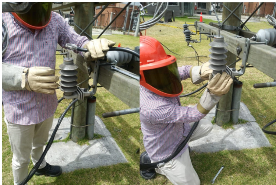
Figura 4-9.: Entrenamiento real para la manipulación de un DPS [6]
