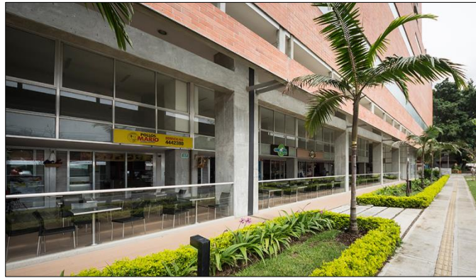
Figura 80: Placa Comercial los árboles, ubicada en plataforma de Unidad Residencial los árboles.
