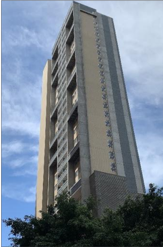
Figura 106: Torre Residencial “Gales”
