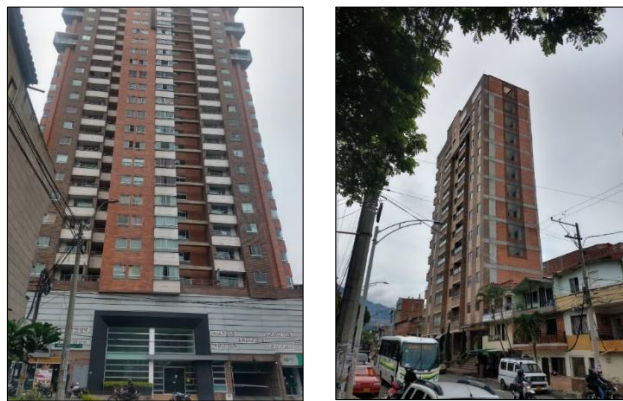
Figura 99: Condominio Santa Clara y Torre Verona, proyectos inmobiliarios multifamiliares de vivienda en altura promovidos en 2013 y 2014.
