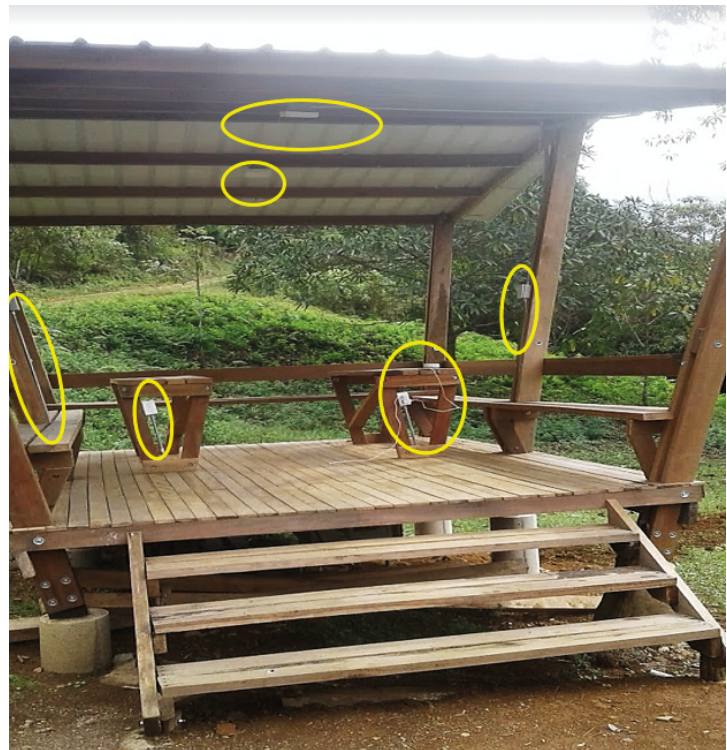
Figura 9. Ubicación de las salidas de energía en el Águila Solar. Fuente: Propia.
