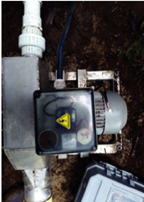
Figura 19. Microturbina y generador "La Elvira". Fuente: Propia.
