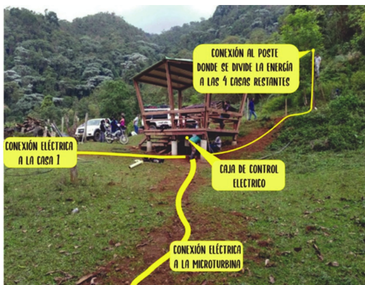
Figura 21. Ubicación caja de control eléctrico. Microturbina "La Elvira". Fuente: Propia.
