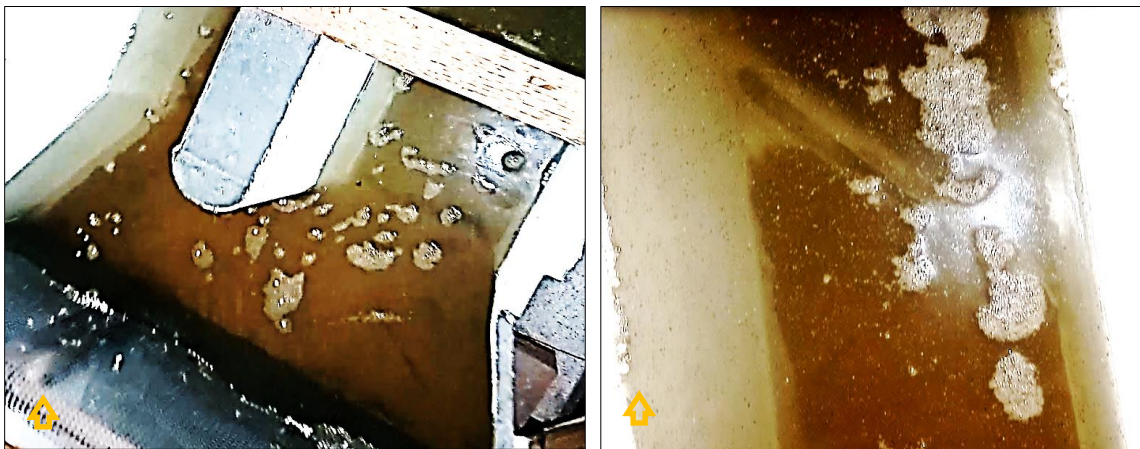
Figura 11-3. Depósito luego de reja de cribado (izq.) y cerca de los excluidores (der.). Caudal Bajo y Abastecimiento Medio
