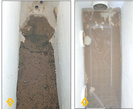
Figura 11-26. Acumulación de sedimentos excluidos (izq.) y cárcamos de bombeo (der.). Caudal Medio Alto y Abastecimiento Alto
