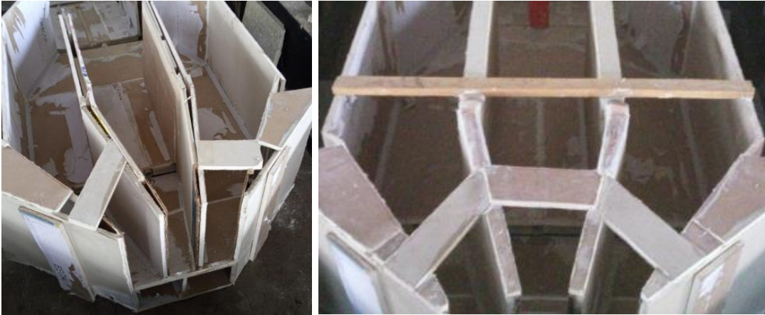
Figura 8-4. Construcción parcial zona de cribado (izq.), zona de cribado finalizada (der.).
