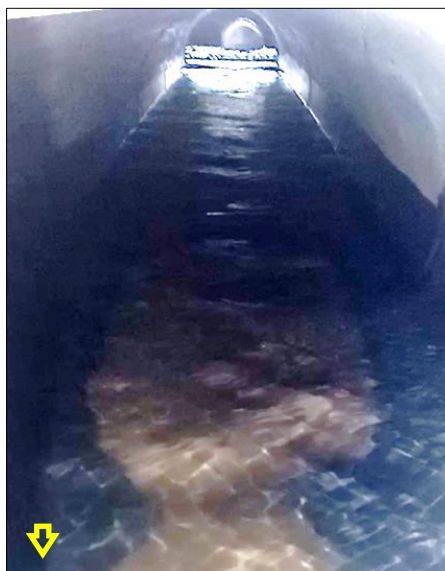
Figura 11-1. Deposición en el fondo del ITC. Caudal Bajo y Abastecimiento Medio
