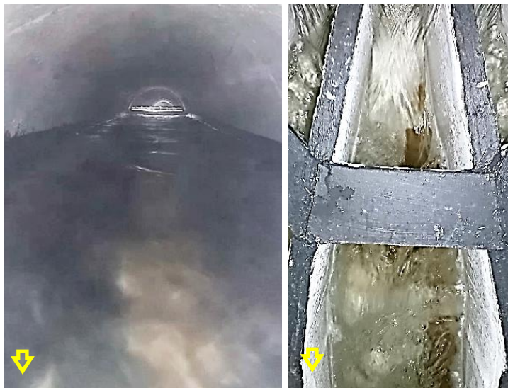
Figura 11-7. Leve depósito en el ITC (izq.) y en zona centro de entrada (der.). Caudal Medio y Abastecimiento Medio
