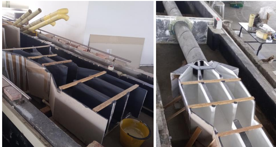
Figura 8-8. Impermeabilización elástica (izq.) y fibrosa (der.).
