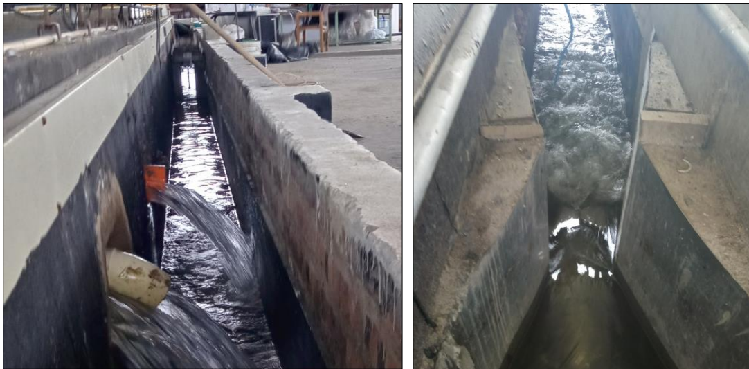
Figura 4-6. Canal de retorno (izq.) y canaleta Parshall (der.) UISA.
