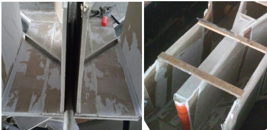
Figura 8-5. Construcción parcial canales de conexión (izq.), canales finalizados (der.).
