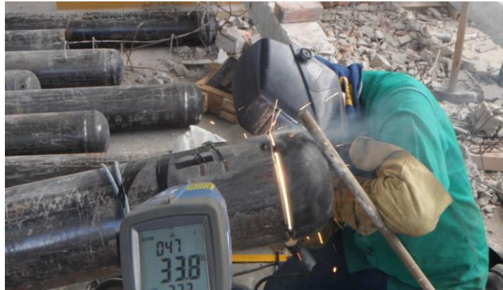
Figura 2-13: Soldado de los caps a los tubos
