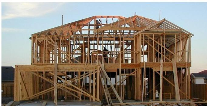
Imagen 60 Estructura de madera sistema balloon Frame Fuente: Tinsa (2015)
