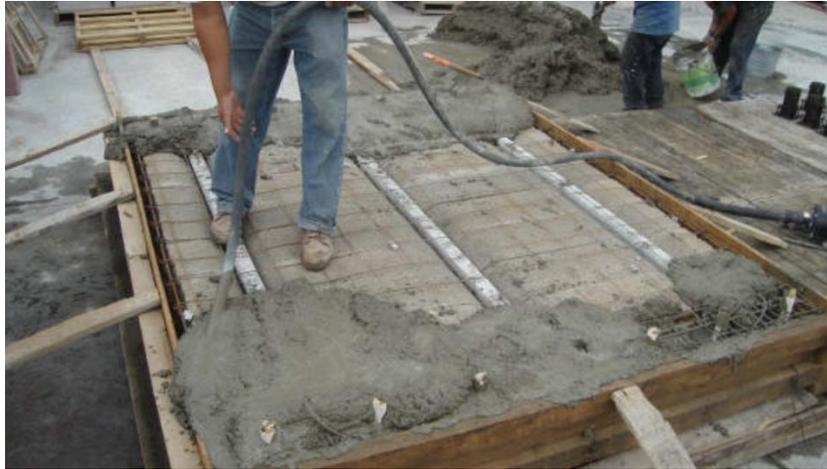
*Figura 11: Vaciado de concreto con modelo de vigueta y bovedilla en concreto.(ANIVIP, 2012) –información suministrada por el laboratorio).*
