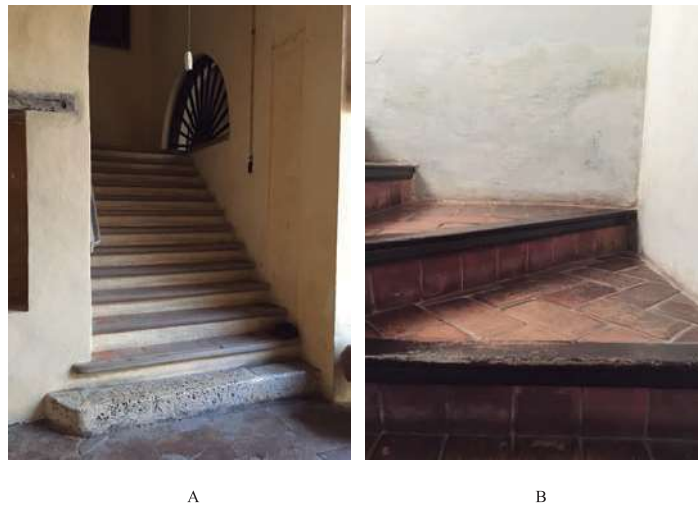
Figura 10. En la arquitectura doméstica islámica, el habitante no puede entrar con zapatos al interior de la casa. Para esto, los materiales del piso, incluyendo las escaleras, tienen narices en madera y son, generalmente, de barro. A) La escalera principal de la Casa Las Marías, en Cartagena de Indias, Colombia, tiene los mismos rasgos constructivos que la escalera (B) de la Casa del Chapíz en Granada, España.
