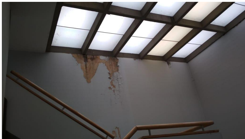
Ilustración 2. Edificio 450, Departamento de Farmacia
