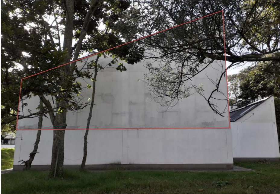
Ilustración 4. Cambio de material en fachada, edificio 425.
