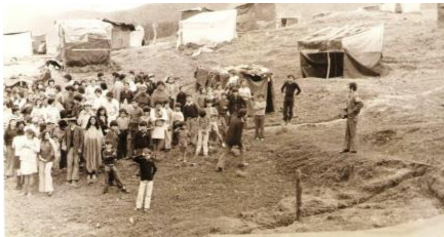
Figura 8. Consolidación del barrio Quindío - Central Nacional Provivienda
