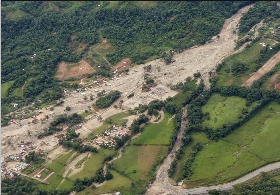
Figura 1. Zonas afectadas de Mocoa por la avenida torrencial. Fuente: Abu Shlhab (2017)
