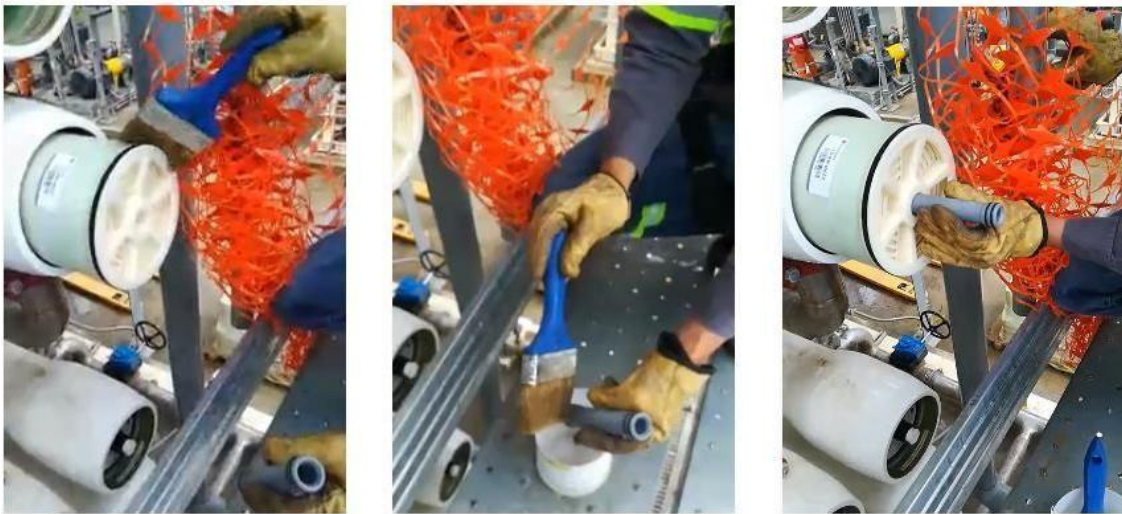
Imagen 6. Lubricación de los sellos de las juntas de las membranas.
