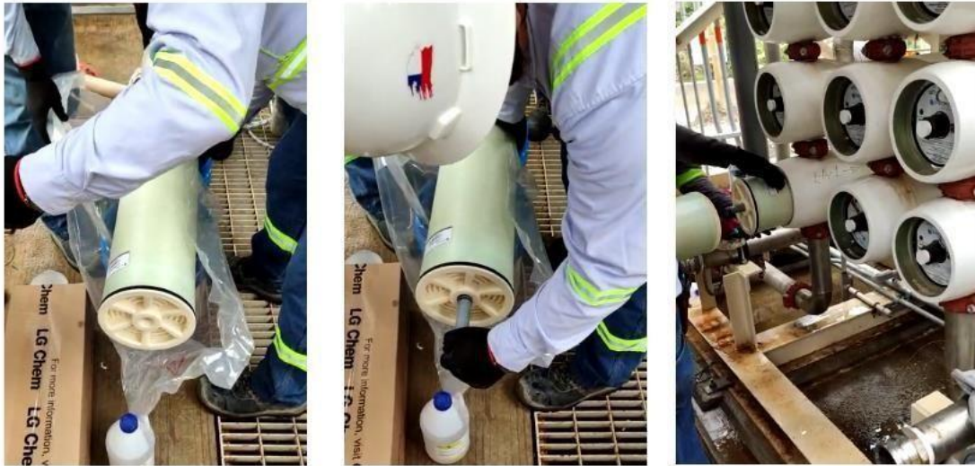
Imagen 7. Instalación de los anillos de empuje en el extremo de descarga del vaso a presión.
