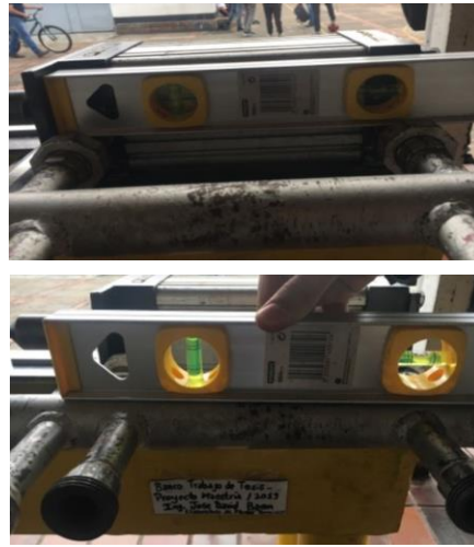
Figura 166. Nivelación de camisa respecto al cilindro
