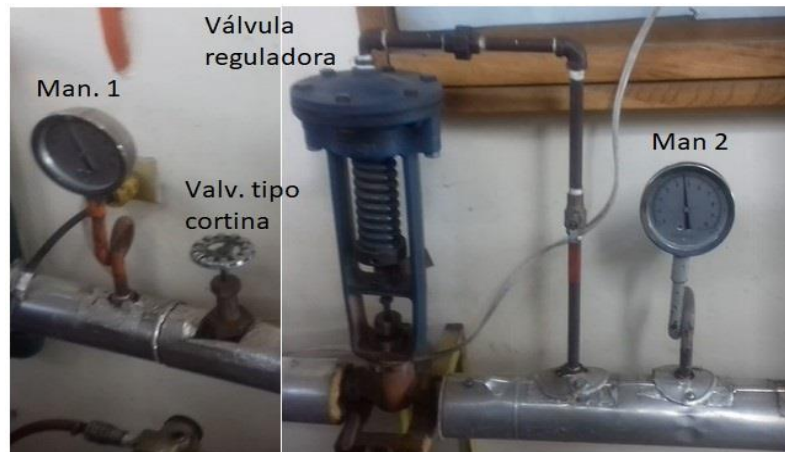
Figura 70 Instalación de manómetros antes (1) y después (2) de la válvula reguladora de la presión.
