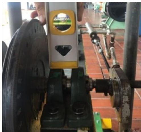
Figura 164. nivelación de cojinetes de arco del eje del volante de inercia.
