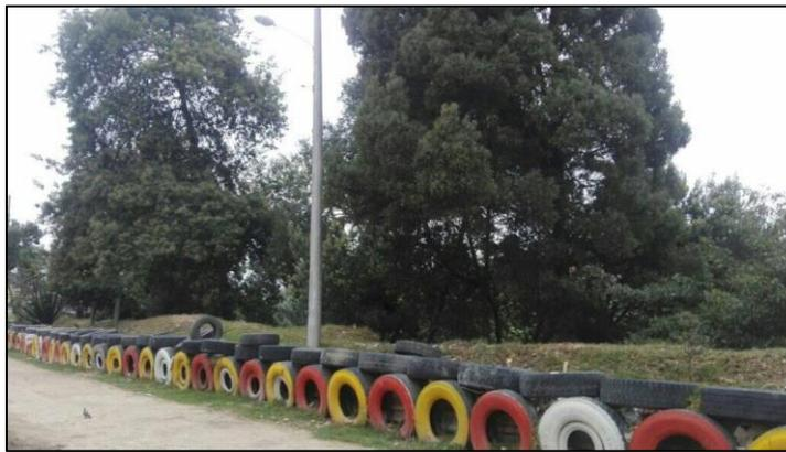
La construcción de este jarillón en particular, fue producto de la gestión comunitaria y el apoyo del edil Jaime Salas. Con la consecución de tierra, escombros de otras construcciones, más de 300 llantas en desuso, y el trabajo colectivo de la comunidad, se construyó el muro de contención. (Horacio). Fotografías tomadas por habitante del barrio en marzo del 2019 y compartidas a la investigación con autorización expresa. Se extraen de la página de facebook del barrio.
