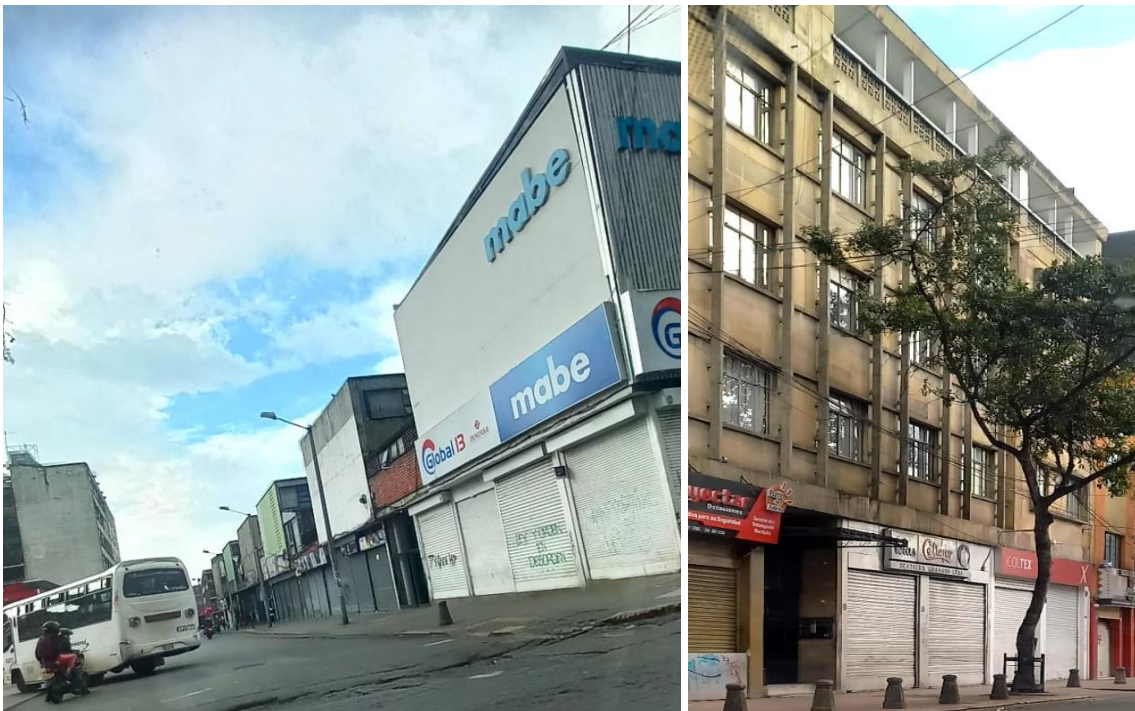
Fotografía 21 Transformación Inmuebles BIC -Comercio-Vivienda- (Fuente Propia)
