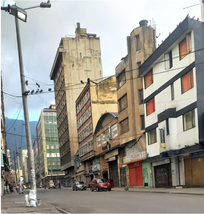
Fotografía 20 Estructura de alturas y tipologías Calle 17 entre Carrera 10 y 12 (Fuente Propia)
