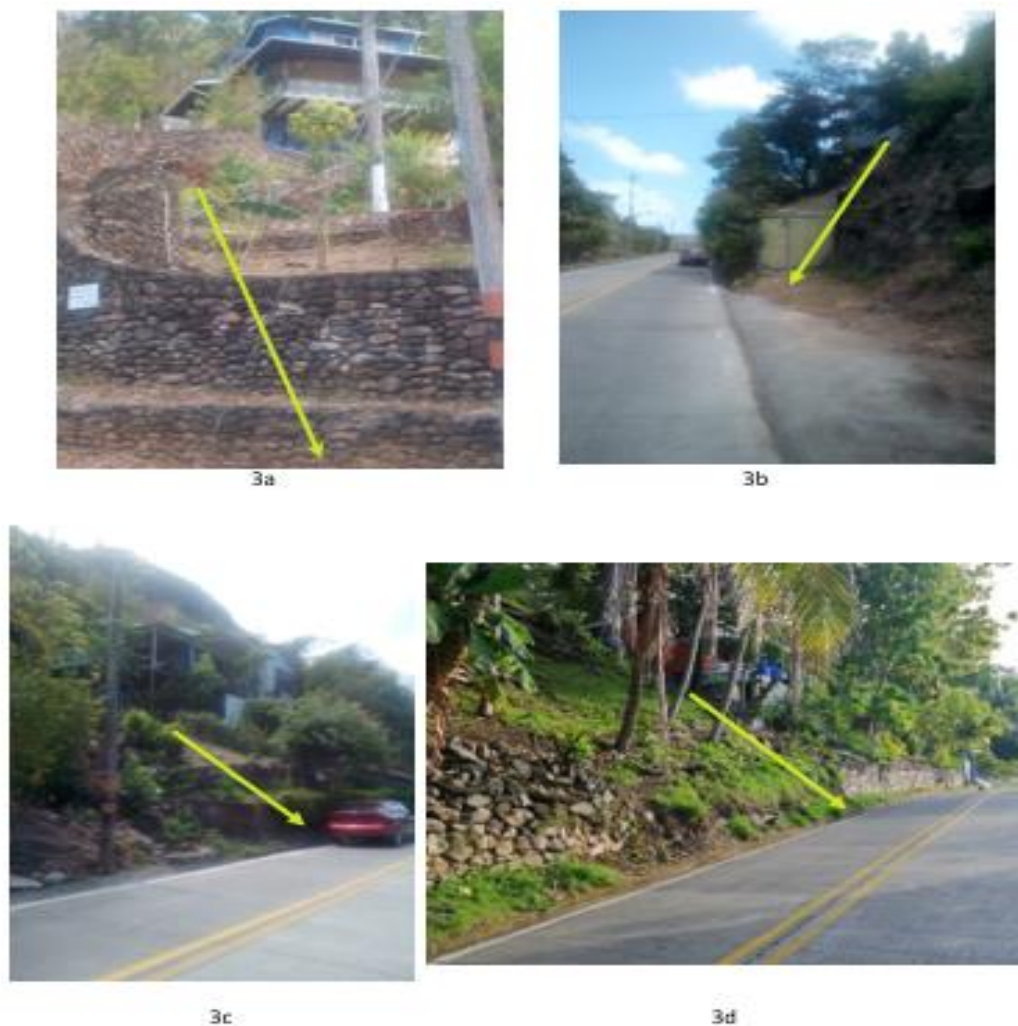
Imagen 3a, 3b, 3c y 3d. Viviendas construidas en lugares de fuerte pendiente resultantes del trazado de la carretera
