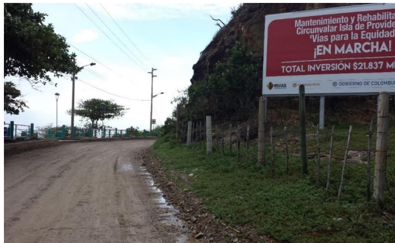
Imagen 9a. Mantenimiento vial, tramo Loggerhead Bluff (tomada en el 2016)
