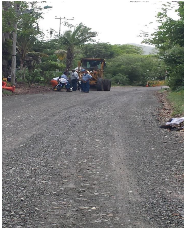
Imagen 9b. Mantenimiento vial, tramo Smooth Water Bay (Tomada en el 2016).
