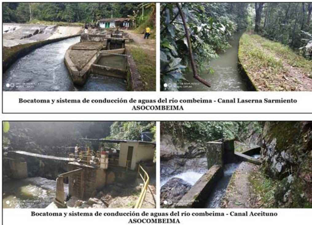
Figura 6-12 Sistemas de captación y conducción de aguas para uso agrícola – río Combeima
