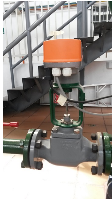
Figura A-17.: Válvula neumática proporcional FV-03.
