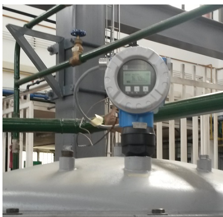
Figura A-4.: Transmisor de nivel ultrasónico LIT-01.
