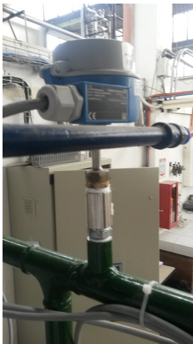
Figura A-9.: Transmisor de presión TT-01.
