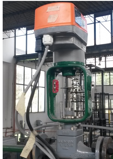
Figura A-19.: Válvula neumática proporcional LV-02.
