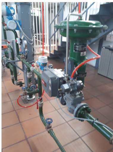
Figura A-12.: Válvula neumática proporcional HV-01.
