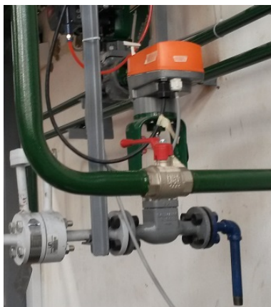
Figura A-16.: Válvula neumática proporcional FV-02.
