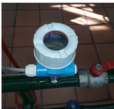
Figura A-7.: Transmisor de presión PIT-01.
