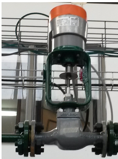
Figura A-18.: Válvula neumática proporcional LV-01.
