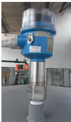
Figura A-5.: Transmisor de nivel capacitivo LIT-02.
