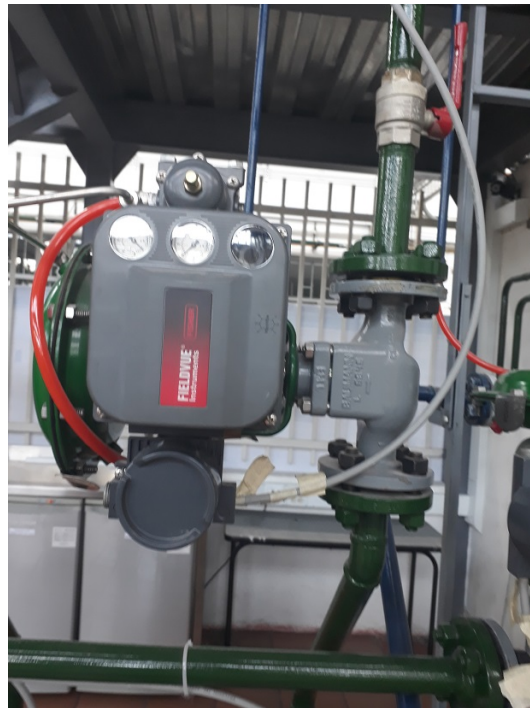
Figura A-13.: Válvula neumática proporcional NV-01.
