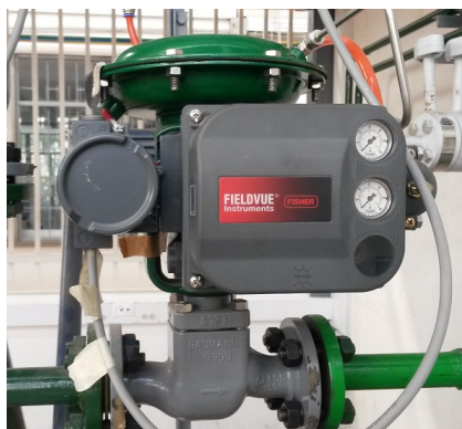
Figura A-14.: Válvula neumática proporcional PCV-01.
