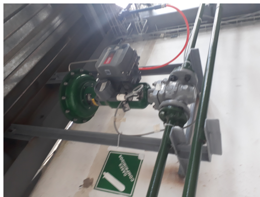
Figura A-11.: Válvula neumática proporcional FV-01.
