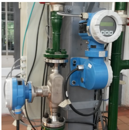
Figura A-2.: Transmisor de flujo FIT-02.
