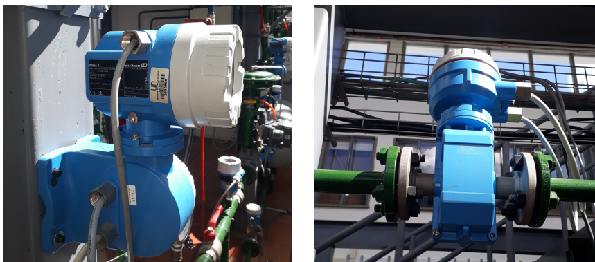
Figura A-3.: Transmisor de flujo magnético FIT-01B.
