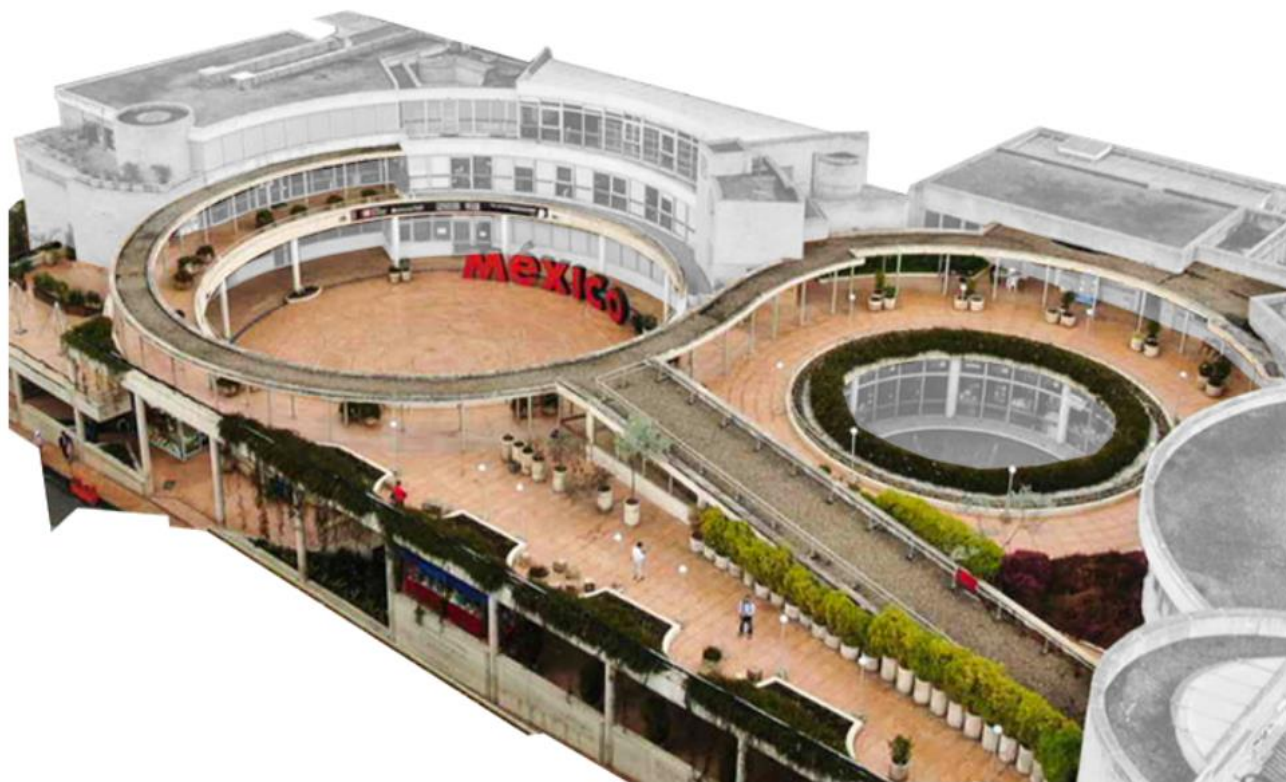
Figura 21. Centro cultural Gabriel García Márquez de Rogelio Salmons, Bogotá, 2008. Vista aérea. En el centro cultural, el espacio continuo conforma un aproximado del 60 por ciento del proyecto, la circulación se funde de forma intencional con las galerías y terrazas y permiten difuminar los límites.
