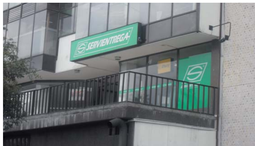
Fotografía 19. Punto de mensajería Sevientrega sobre la Calle 62.
