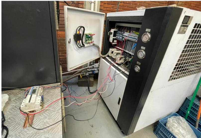
**Figura 6-2:** Instalación de registradores de consumo eléctrico.
