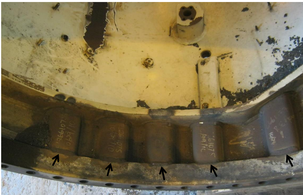
Fotografía C-6: “channels” de refuerzo en parte alta instalados.
