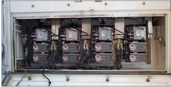
Figura 2-14: “Choppers” de frenado.
