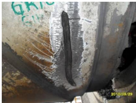
Figura 2-33: Reparación sin desmontar el mando final (lado A).
