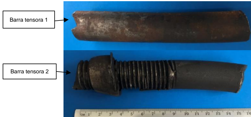
Figura 3.11: Secciones fracturadas de barra tensora.
