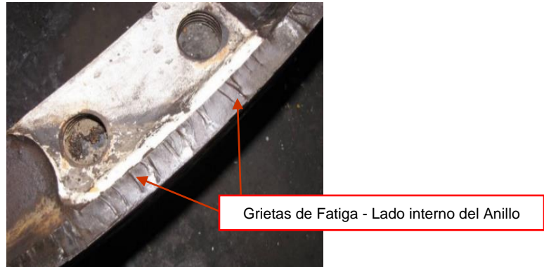
Figura 2-23: Grietas de fatiga desde la parte interna - Junta anillo-metal base.
