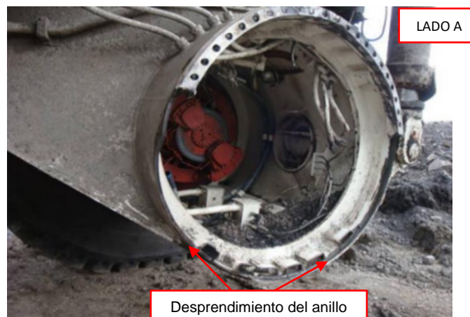
Figura 2-26: Fractura & desprendimiento de anillo y mando final (Lado A).
