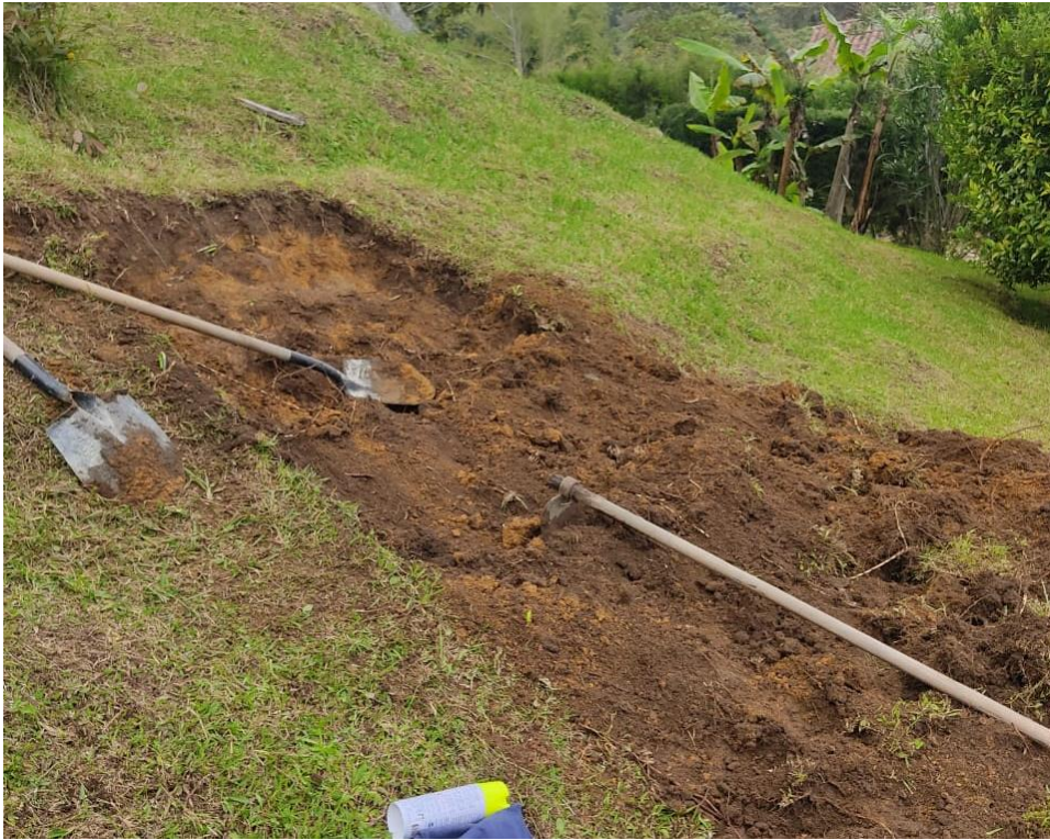
Figura 17. Proceso de construcción de la parcela de prueba
