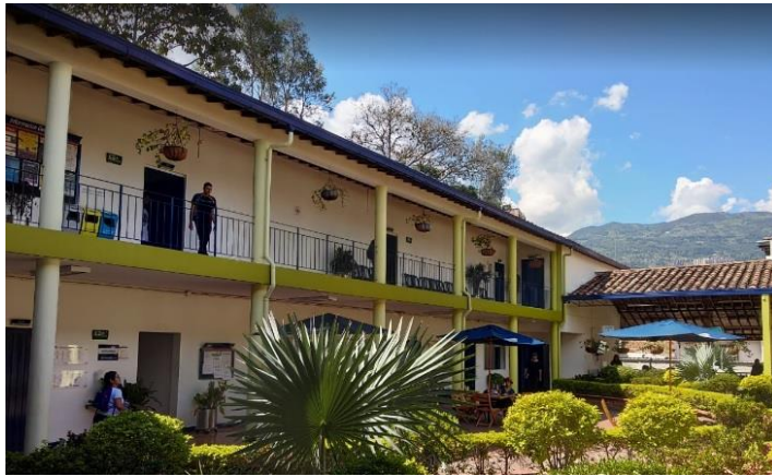
Figura 8. Escuela Popular de Arte, c. 1992. De izquierda a derecha: ampliación de la sede y vista del patio interior desde segundo piso. Fotografías cortesía de Nelson Osorno.
