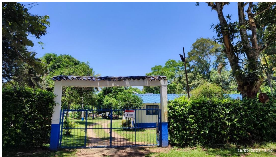
Ilustración 13 Vivienda aislada de la vía Fuente: elaboración propia
