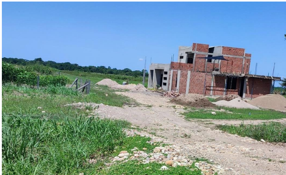
Ilustración 11 vivienda con bloques y revestimiento en la vía Matepantano Fuente: elaboración propia
