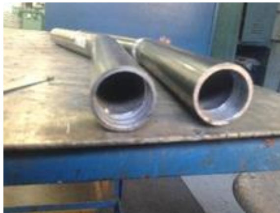
Figura 3-11: Preparación de extremos de tubería para el ensamble.
