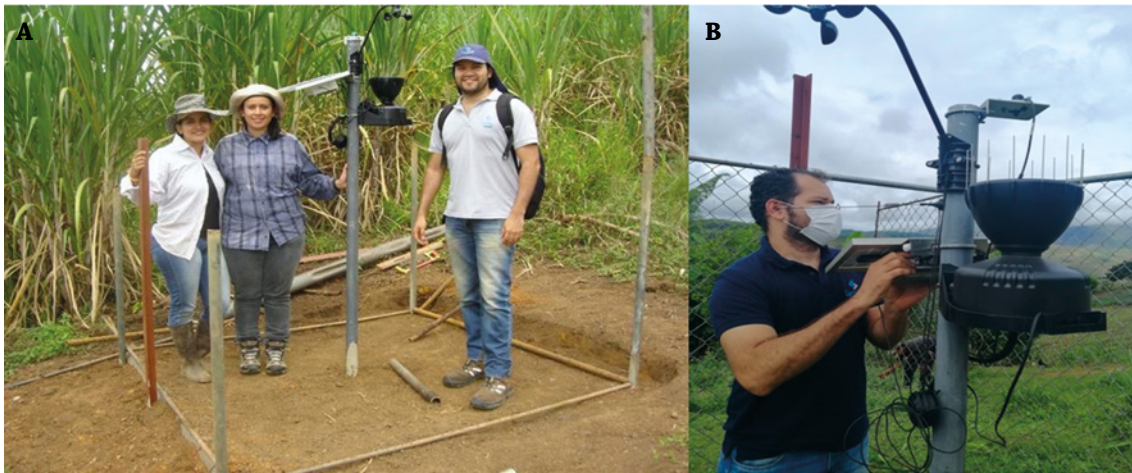
Figura 6. A) Instalación de la estación meteorológica. B) Mantenimiento de los equipos de la estación meteorológica
