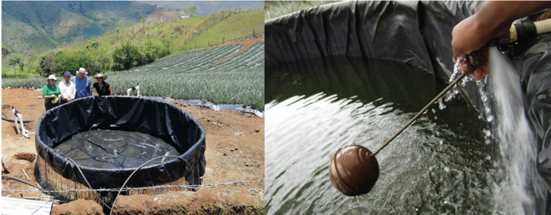
Figura 8. A) Instalación del tanque Zamorano en la parte alta de la parcela demostrativa de piña MD2. B) Almacenamiento de agua en el tanque zamorano
