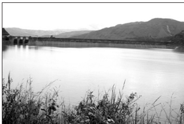
Muro de Contención de cara al embalse Salvajina.
