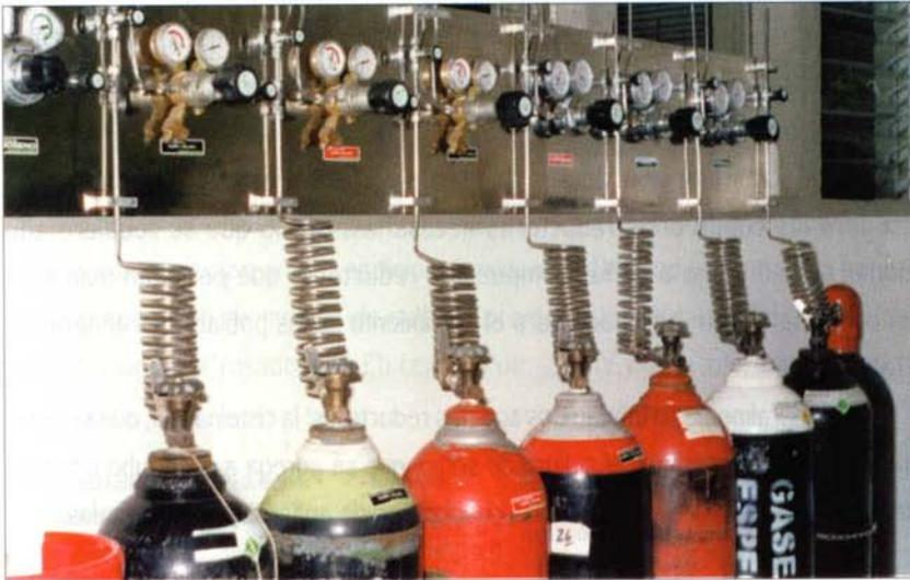
Figura 5.7. Sistema de distribución de gases.
