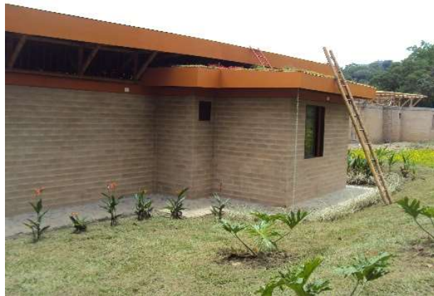
Figura 2. Aspecto general de V1; obsérvese la ventilación superior para regulación pasiva de temperatura interna.
