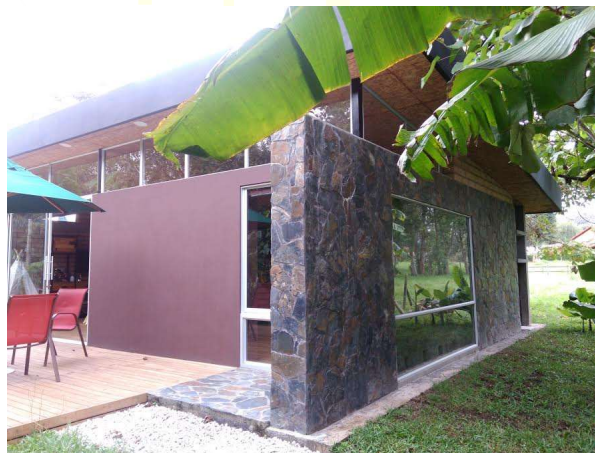
Figura 4. Aspecto general de V2. Muro captador de energía solar en habitación.
