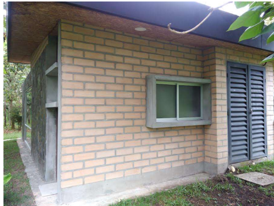
Figura 5. Aspecto constructivo en mampostería confinada en BSC de V2.
