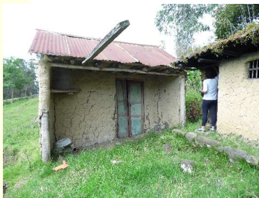
Ilustración 8. Registro fotográfico y medición de vivienda en bahareque en zona rural del municipio de Ramiriquí.
