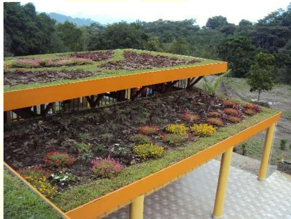
Figura 3. Cubierta verde en V1. Estructura de soporte en guadua.
