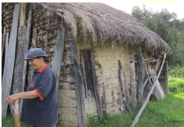
Ilustración 6. Entrevista y visita a construcción en bahareque en la zona rural del municipio de Tinjacá.
