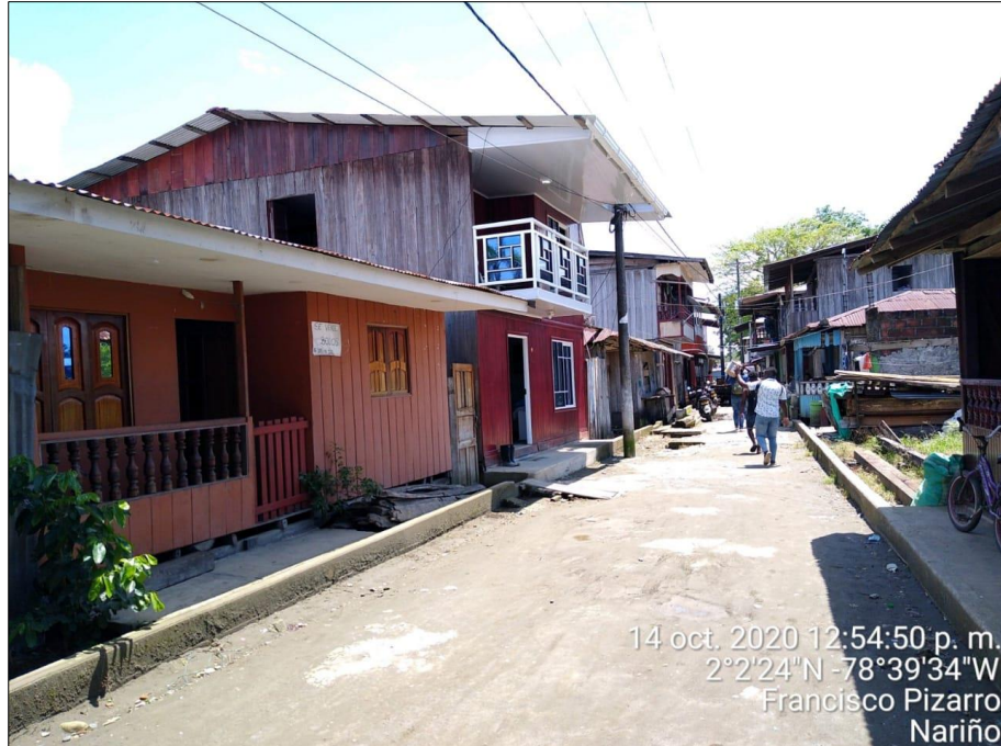
Figura 2-5: Fotografía de viviendas de paneles de madera en Salahonda
