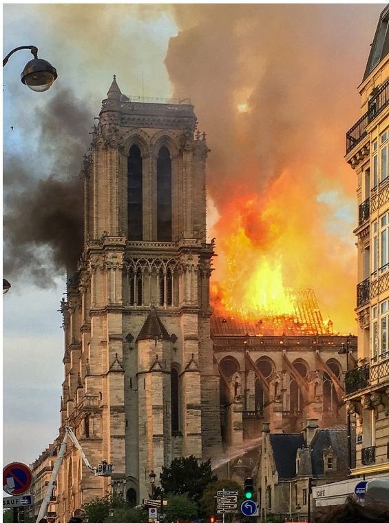
(a) Incendio del tejado de Notre Dame
