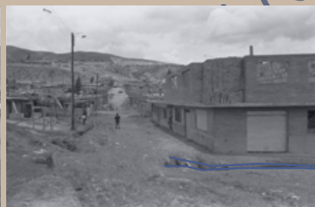
Imagen 60 Calle y paso del canal
