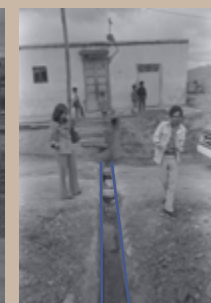
Imagen 59 Canal de aguas
